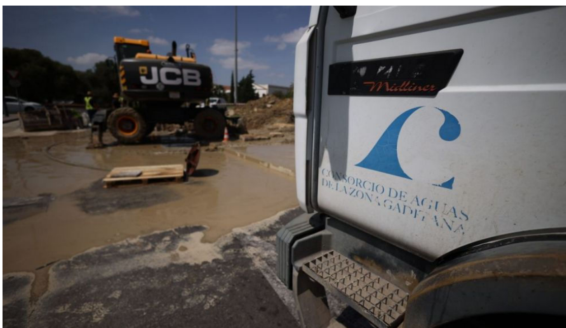
El Consorcio de Aguas de la Zona Gaditana está realizando obras en la arteria 1, que abastece a los depósitos de Montealto, Trebujena y los generales de San Cristóbal.
