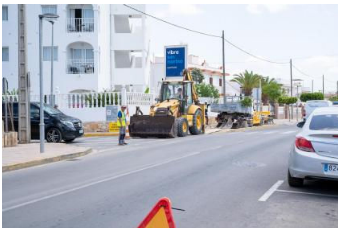
Empleados de Aqualia trabajando este martes por la mañana en la zona afectada. | Alejandro Mellon
