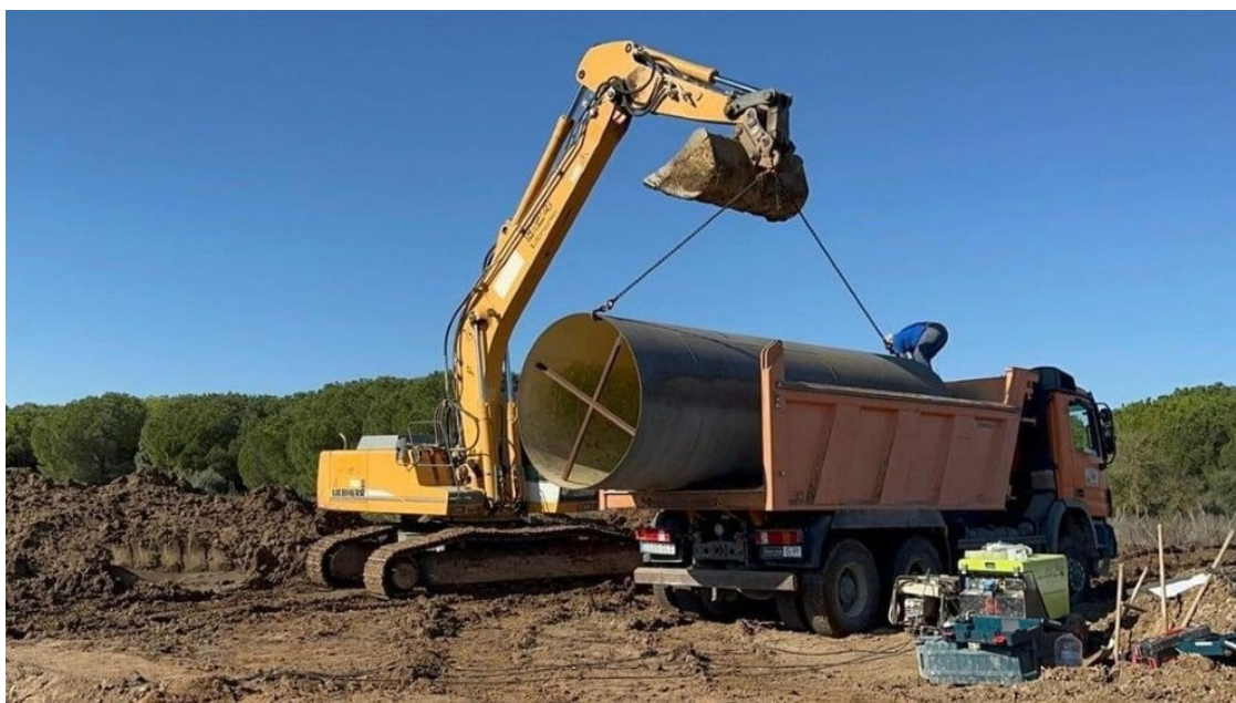
Reparación de una conducción de agua
