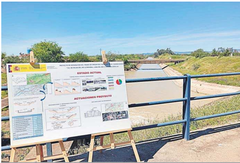
Tramo de origen del Canal del Bajo Guadalquivir situado entre Palma del Río (Córdoba) y Lora del Río.
